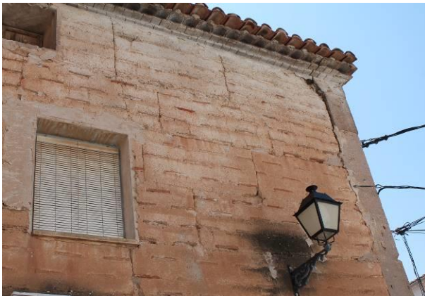
Figura 3. Tapia calicostrada careada con ladrillo y con rafas de yeso en las esquinas
